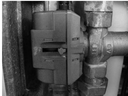
Aanzuiging van leidingwater via de terugstroombeveiliging
